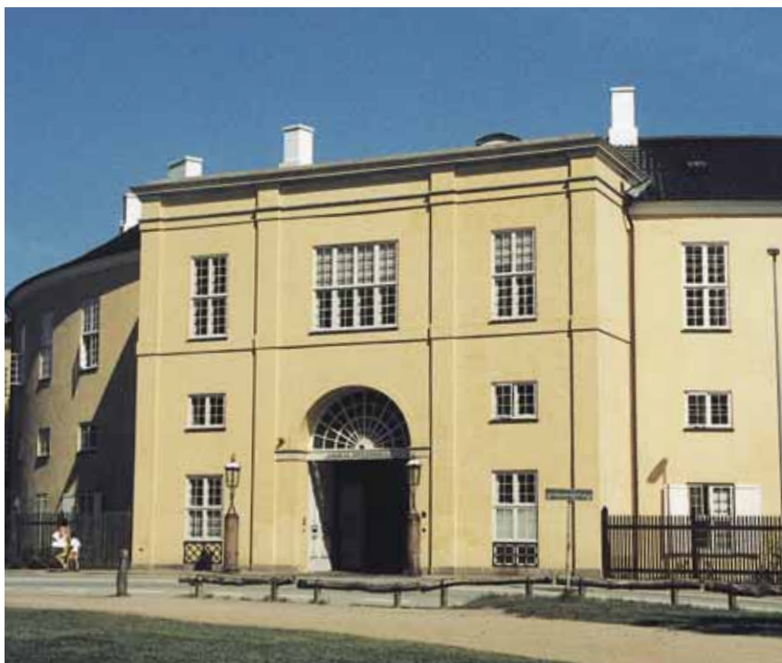
Porthuset efter restaureringen
