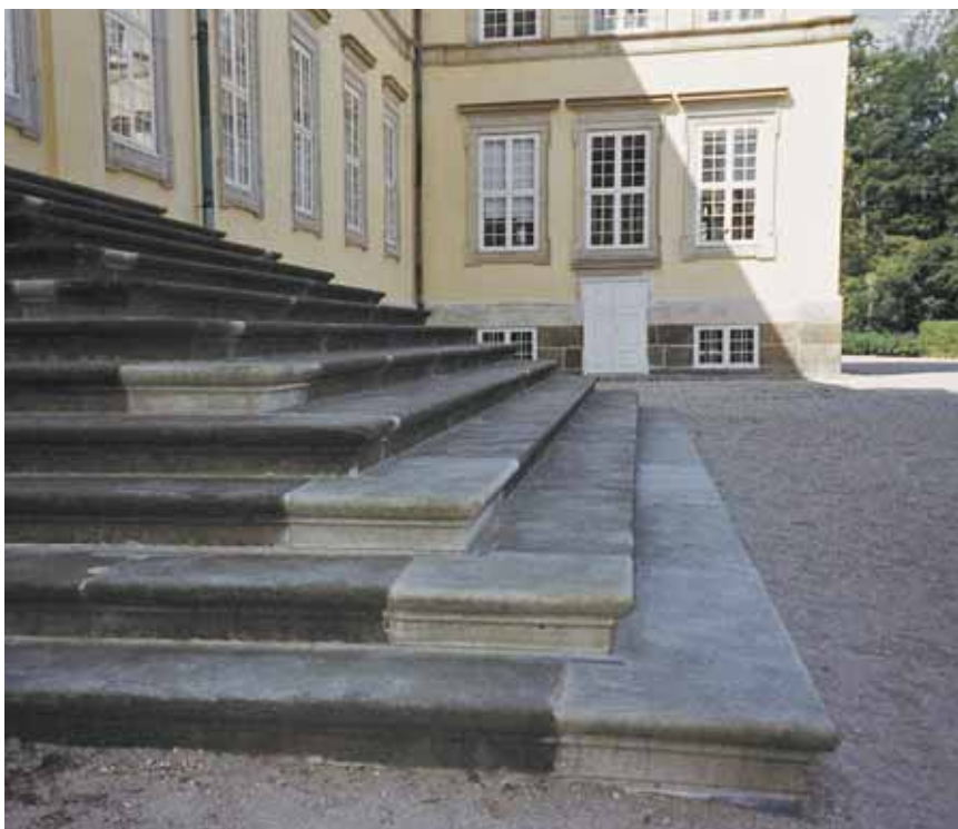
Den restaurerede havetrappe
