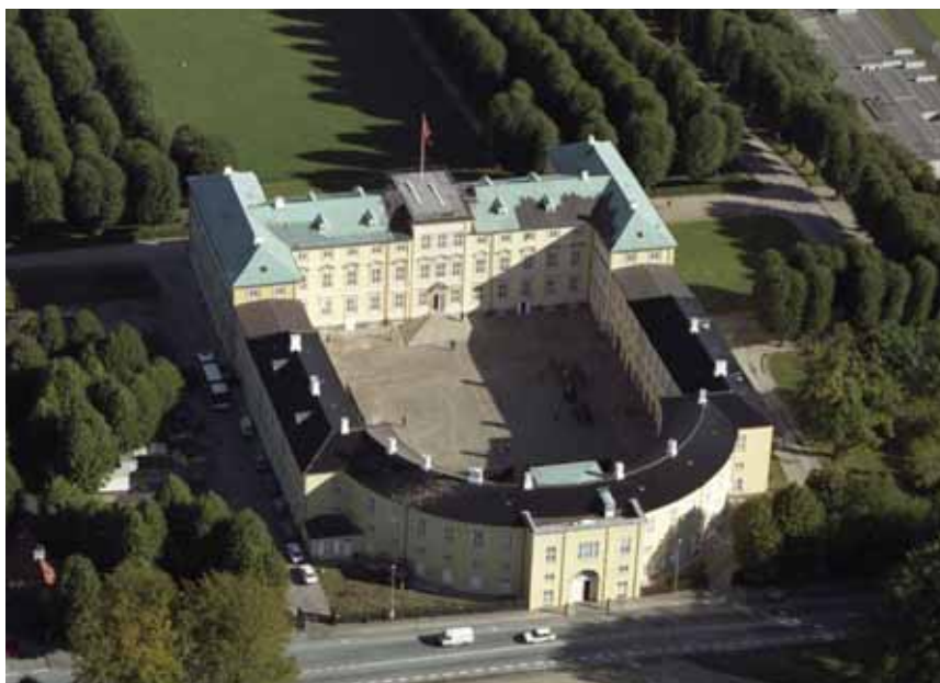
Underretagen og hovedtrappen ses nederst i hovedfløjen
